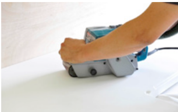
Do zeszlifowania połączeń na gładko użyć szlifierki taśmowej z taśmą 100 lub 120 P
