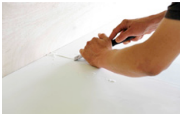
Miejsca, których strugiem nie można dosięgnąć strugiem, oczyścić ostrym szerokim dłutem.
